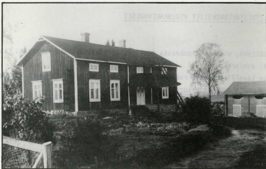
PUOLITOISTAKERROKSISET TALO VÖYRILTÄ
