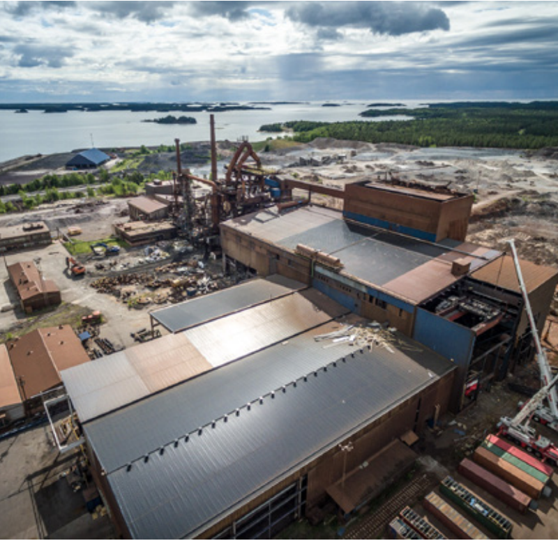
▲ Kovehar under nedmonteringen och rivningen 2014–2017. Foto: Johan Ljungqvist.
